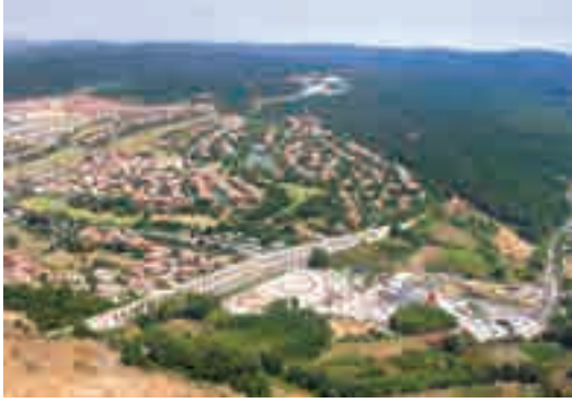
Kırkçeşme Su Yolu, İstanbul.
