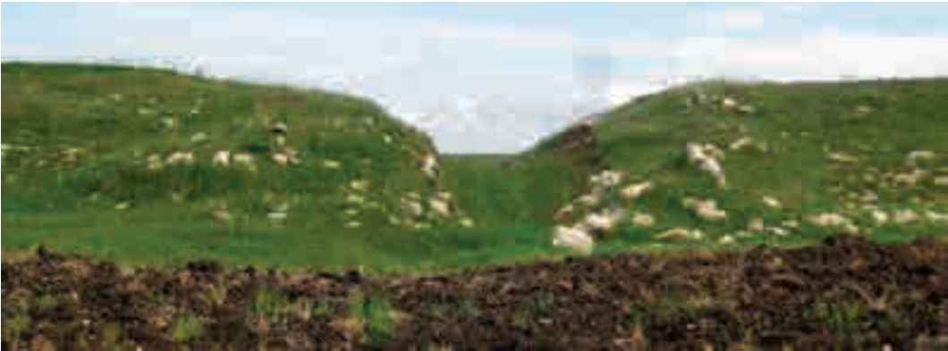
Karakuyu Barajı, Kayseri.
