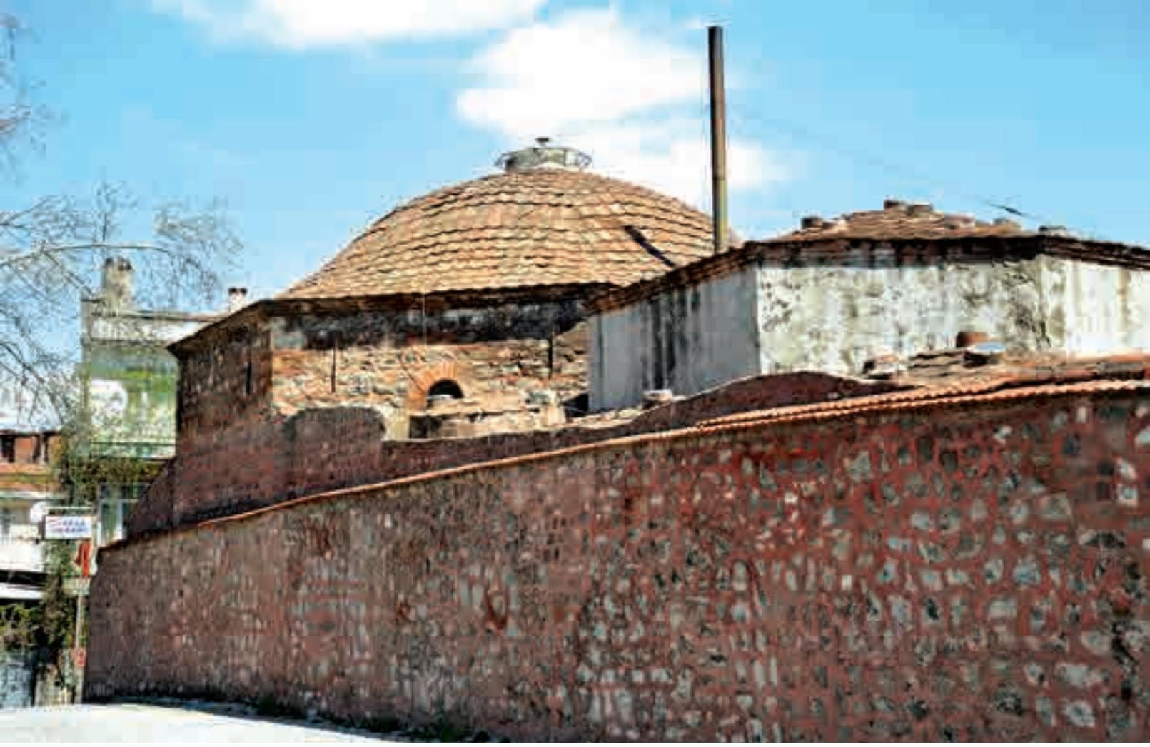
Paşa Hamamı, Balıkesir.
