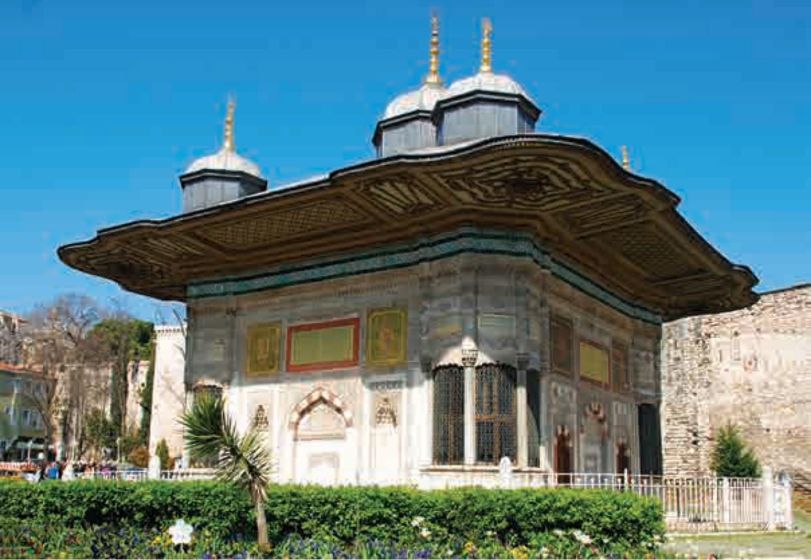
III. Ahmet Çeşmesi. İstanbul'da Topkapı Sarayı'nın giriş kapısı ile Ayasofya arasında Nevşehirli Damat İbrahim Paşa'nın önerisiyle III. Ahmet tarafından inşa ettirilmiştir. Türk rokoko tarzının en güzel örneklerinden olan bu çeşmeyi Mimar Ahmet Ağa yapmıştır.
