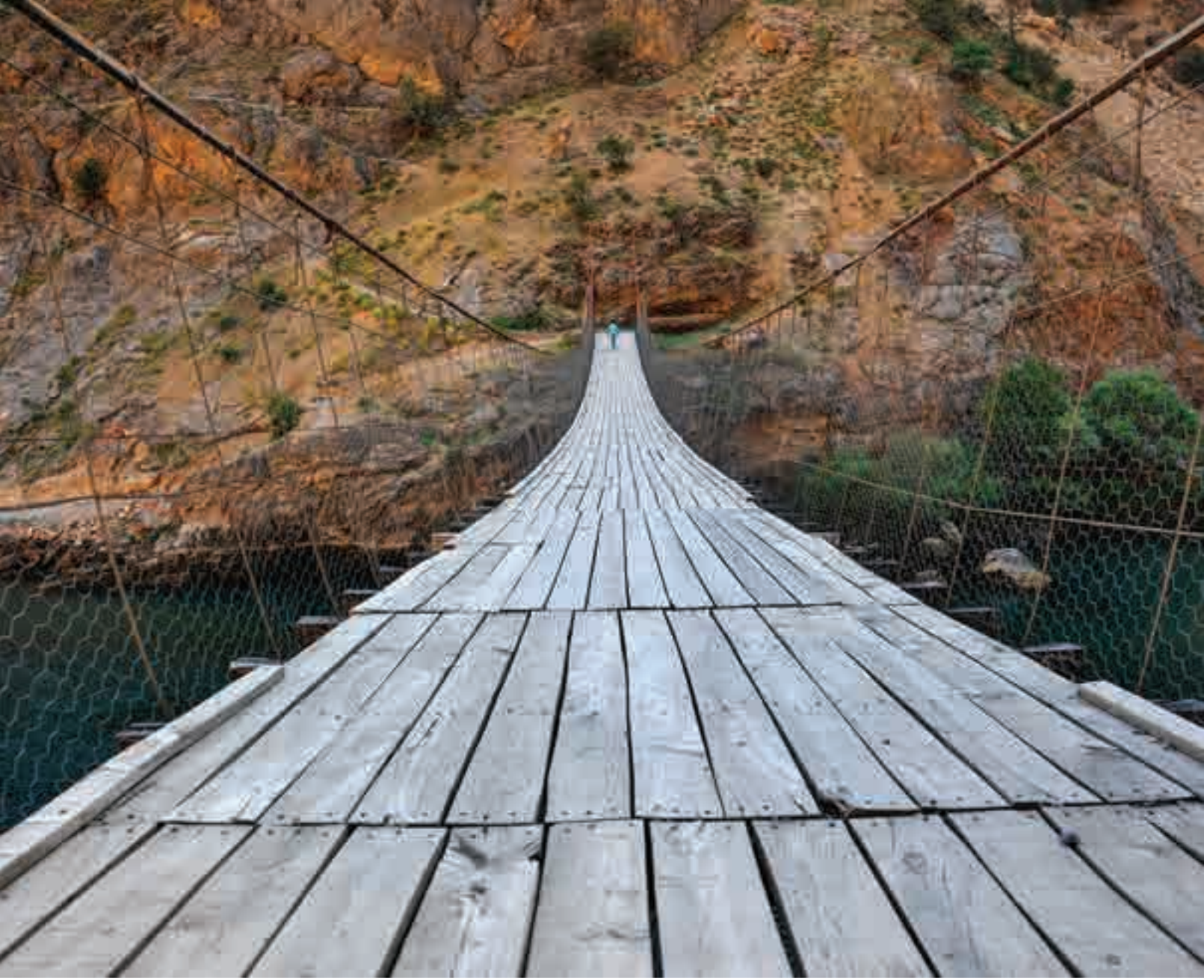
Peri Çayı üzerindeki Karakoçan'ı Tunceli'ye bağlayan asma köprü.
